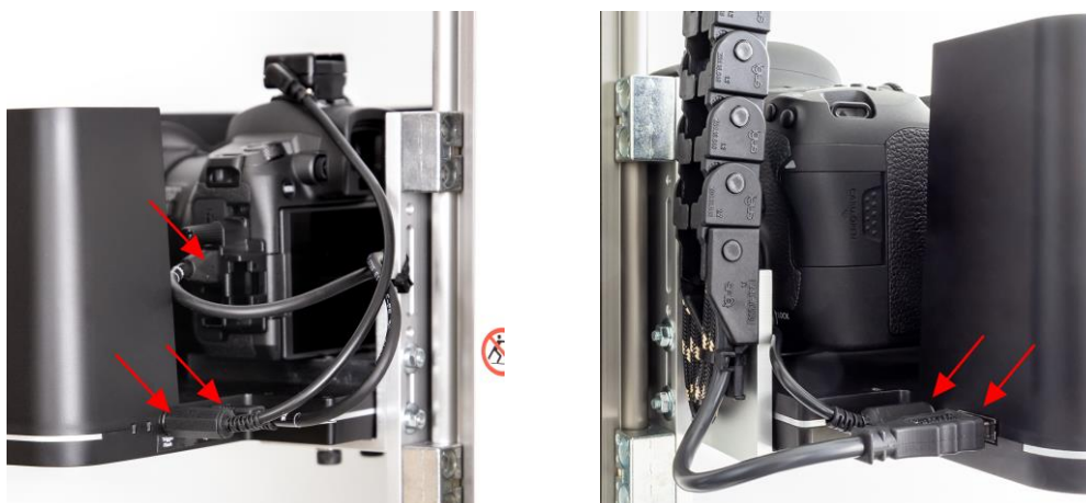
Slika 5: Kabelske povezave PolFlash XE in kamere s stolpom ATBM (pogled z leve in desne)
